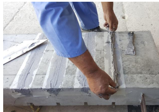
(d) Insert the FRP strips in the groove
