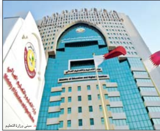
مبنى وزارة التعليم
