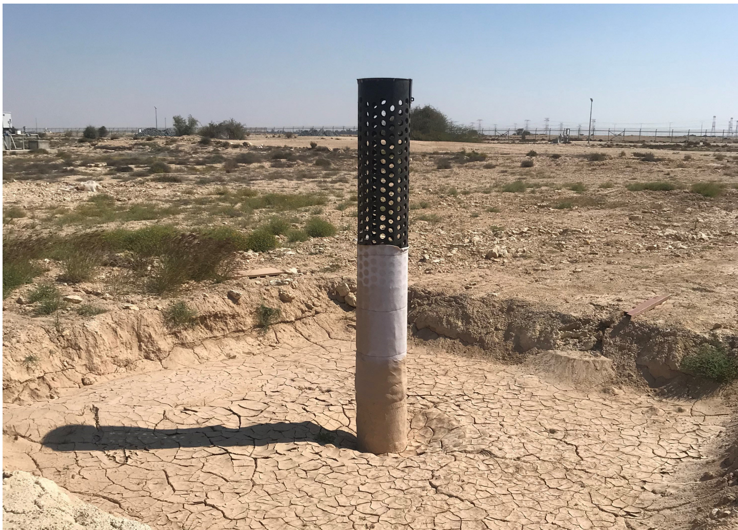
Rainfall-recharge well أحد آبار تغذية مياه الأمطار
