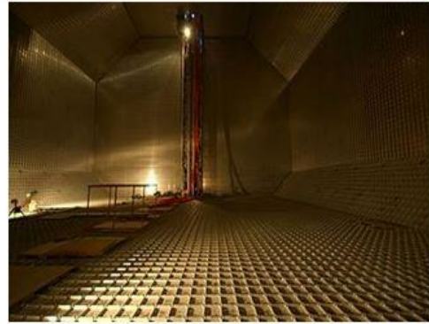
LNG Membrane Tank
