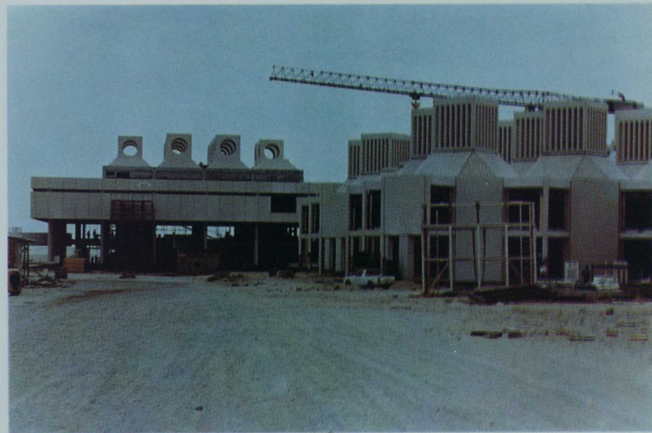
جانب من مبنى البنين وخلفه الإدارة
