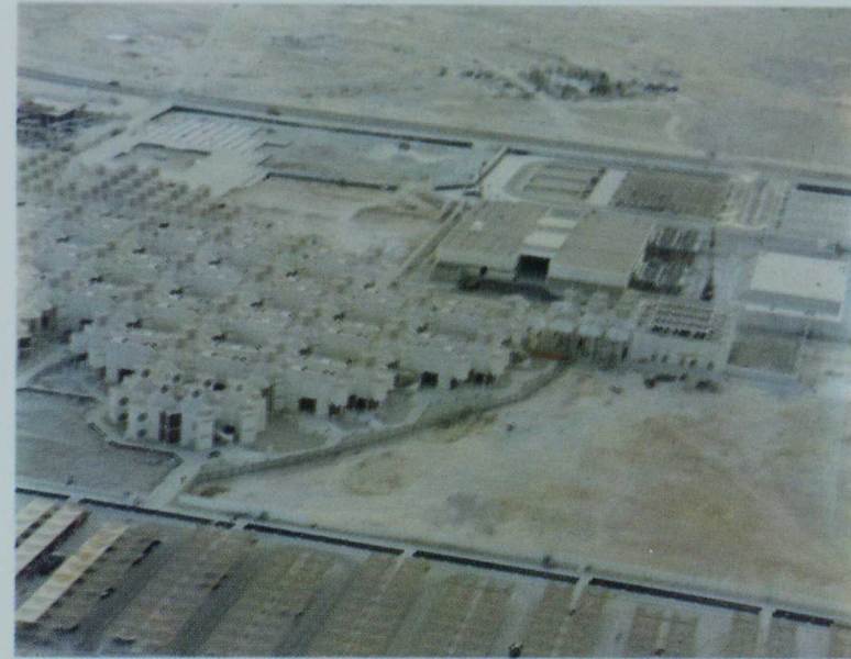
مبنى البنين ووحدة الخدمات المركزية وخزان المياه
