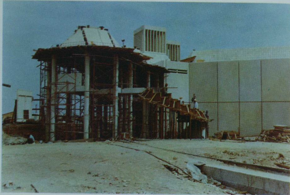
وحدة المباني - المثمن - واتصالها بالدرج الخارجي
